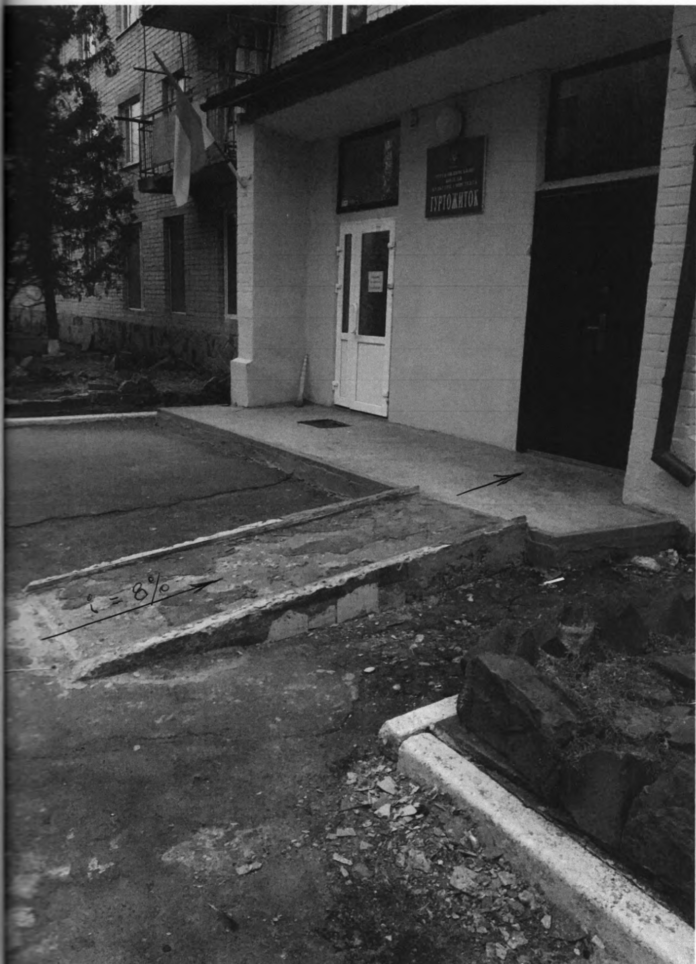
ФОТО 2 - ФАССА ГОТОВОГО ВХОДУ В БФВ ПЛО ГУРЛОЖИТОВУ СПРАВУ ЗОВНІШНІЙ ЗІДНО П. 5.3.1 ДБН В2.2-40:201
